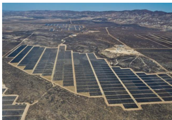
Рис. 3. Солнечное ранчо (California Valley Solar Ranch) - 250 МВт станция в долине Калифорнии
