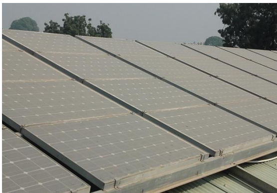
1-rasm. Quyosh panellari ishlash samaradorligiga ta’sir ko‘rsatuvchi omillar(Chang uyumi va ta’sir ko‘ratuvchi soya).
