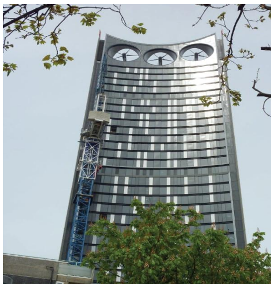
23-rasm . London minorasi. Londonning Elephant and Castle mahallasidagi Strata Tower 43 qavatli, balandligi 147 metr bo'lgan bino bo'lib, uchta besh qanotli o'rnatilgan shamol turbinasiga ega.
