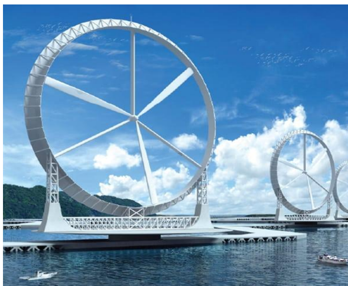
11-rasm. Shamol linzalari. Dengizda o'rnatish uchun qoplangan gorizontal o'qli shamol turbinasi
