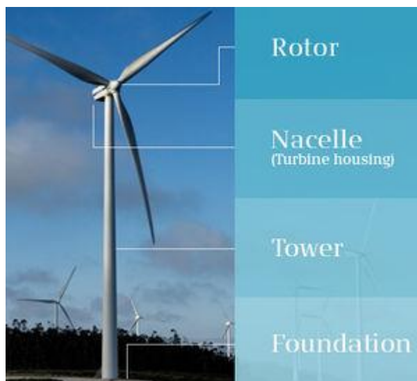
39-rasm. Shamol turbina konstruksiyasi
