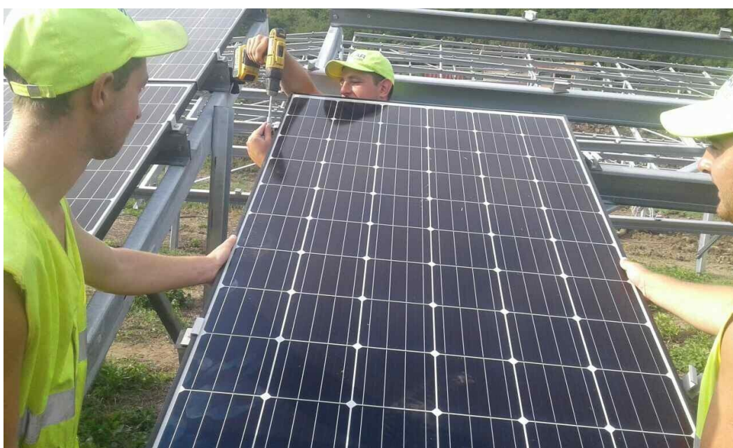
2.13-rasm. Quyosh fotoelektrik stansiyasida quyosh panellarini o'rnatish
