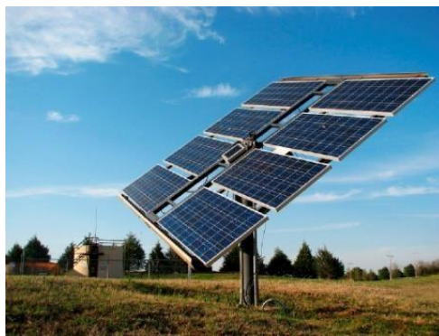
2.15-rasm. Ikki o'qli treker quyosh elektrik stansiyasi
