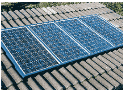
2.2-rasm. Quyosh moduli qurilmasini uy tomida o'rnatilgan xolati
