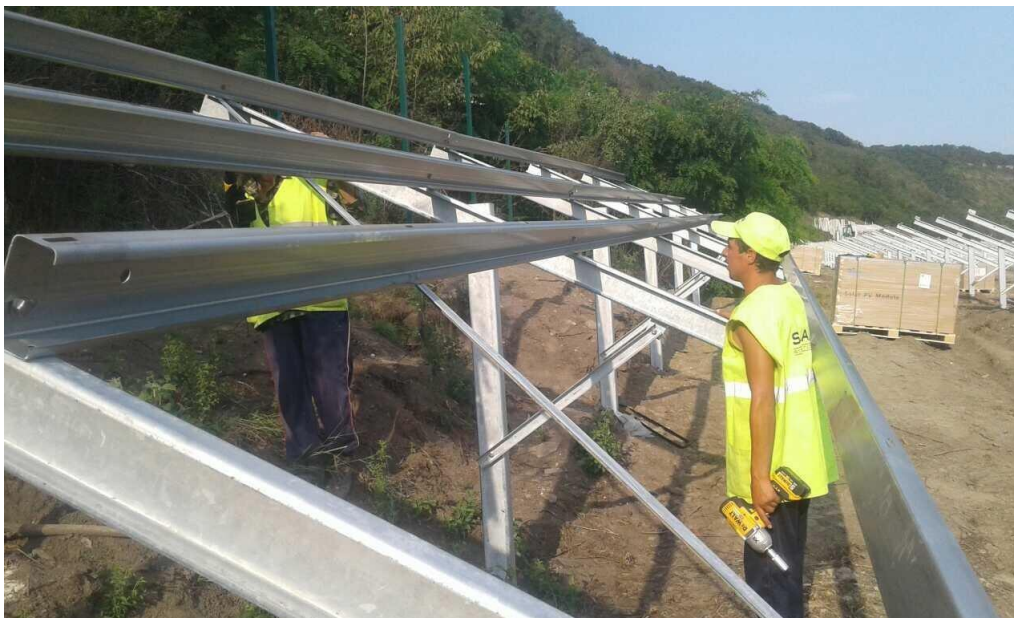
2.11-rasm. Quyosh fotoelektrik stansiyasining karkas qismini o'rnatish
