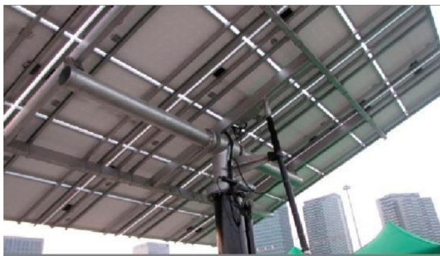
2.15-rasm. Ikki o'qli treker quyosh elektrik stansiyasi
