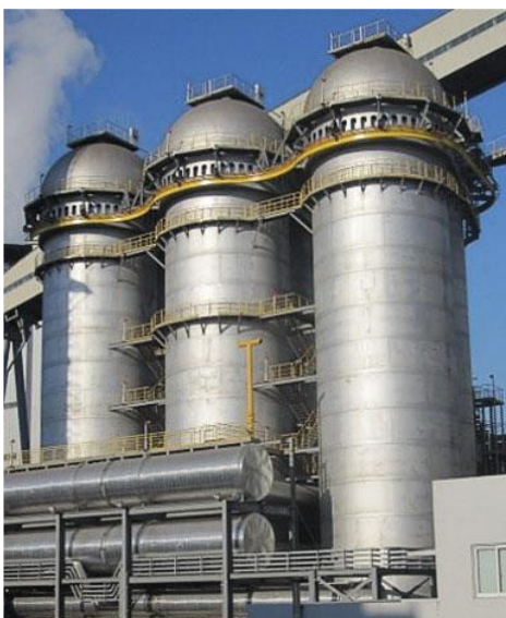
5.5.7-rasm. Qattiq moddalarda sezgir issiqlikni saqlash uchun regeneratorda (yoki Cowper).
