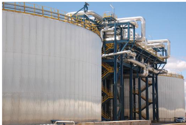
5.5.15-rasm. Andasol-3 quyosh-issiqlik elektr stansiyasida ikki bak-akkumulyatorli eritilgan tuz tizimi (DLR bu rasm uchun ruxsatga ega).
