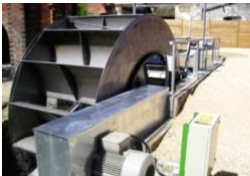
21-rasm. Gidro turbinasi charxpalak shakli mikro GES ko'rinishi.
