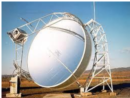
15-rasm. Quyosh issiqlik energiyasi asosida elektr energiya olish tizimi.
