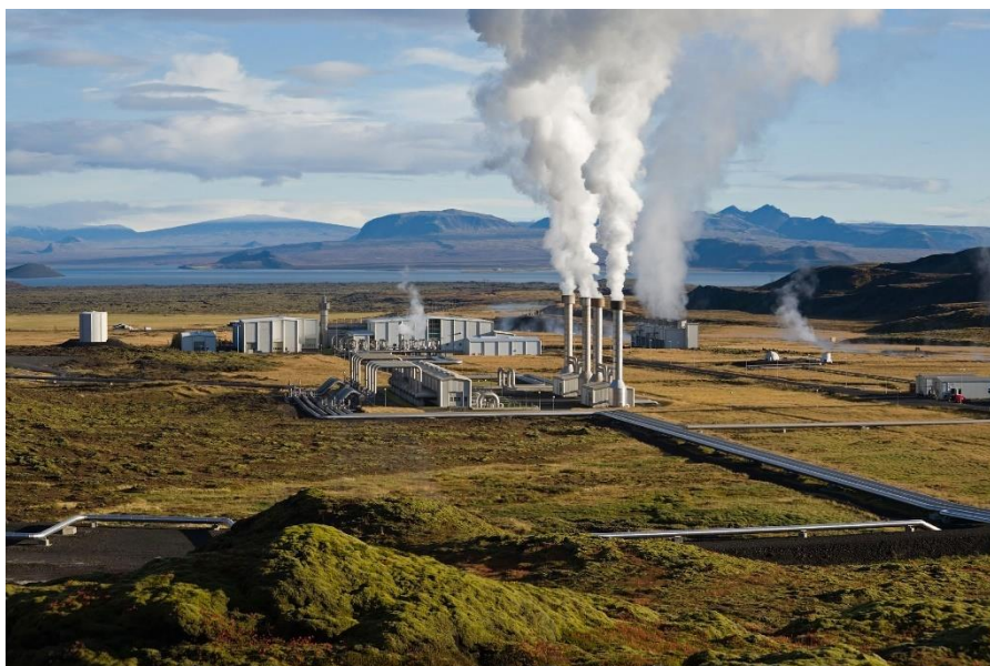
29-rasm. Geotermal elektr stansiyaning umumiy ko‘rinishi.
