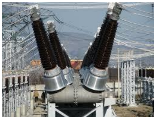
62-rasm. Yuqori kuchlanishli tarmoqlarda qo'llaniladigan elegazli o'chirgich.
