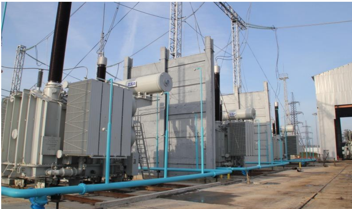
53-rasm. Bir fazali avtotransformatorlarning umumiy ko‘rinishi.
