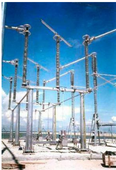
63-rasm. Yuqori kuchlanishli tarmoqlarda qoʻllaniladigan ajratkich.
