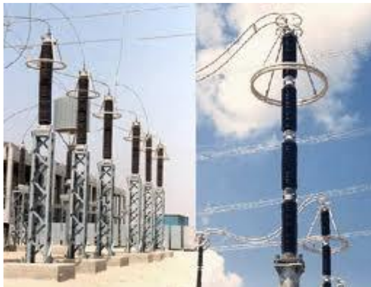
66-rasm. Yuqori kuchlanishli tarmoqlarda qo'llaniladigan razryadnik.
