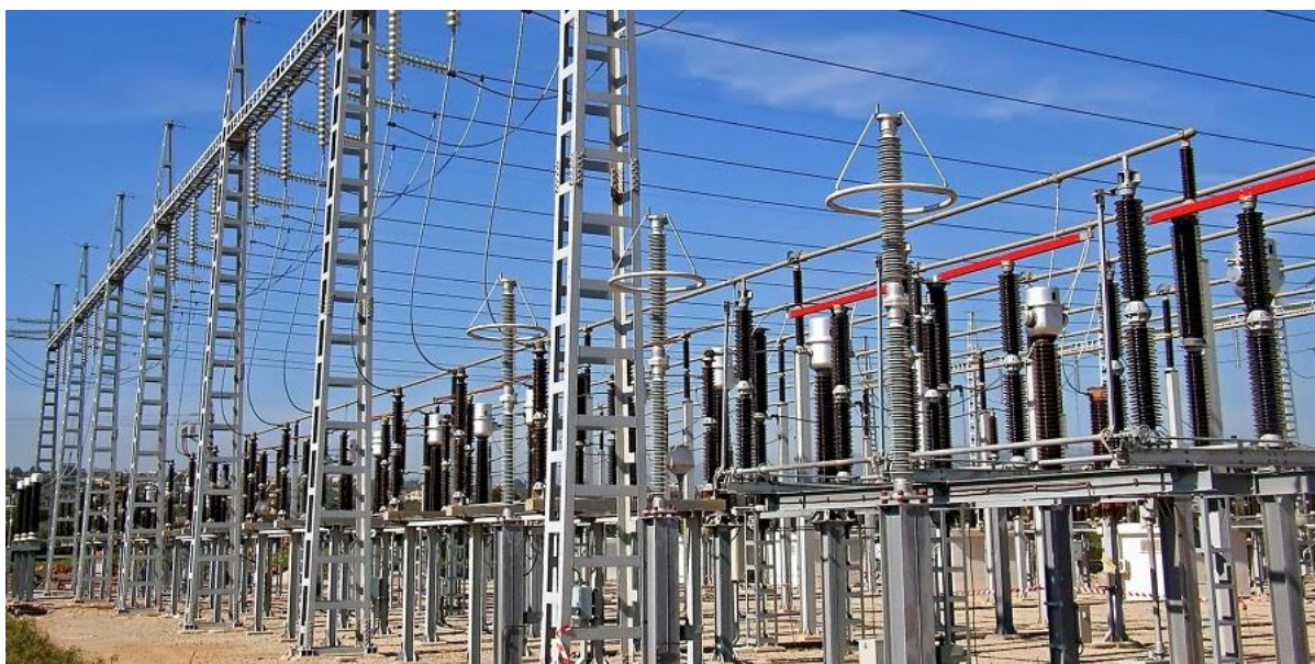
60-rasm. Yuqori kuchlanishlarda qo'llaniladigan ochiq taqsimlash qurilmalari.
