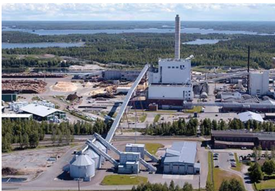
7.1-rasm. Dunyodagi eng katta biomassa yoquvchi stansiyaning ko'rinishi.
