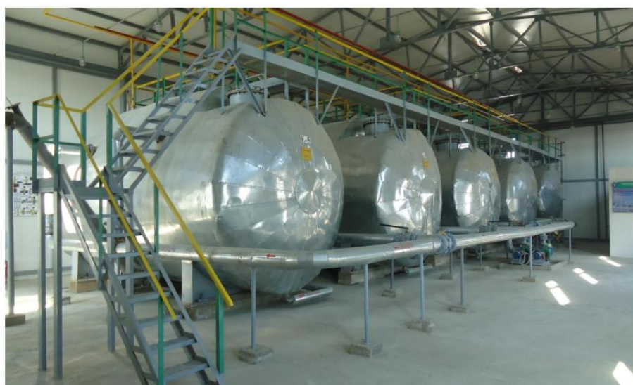
7.17-rasm. Buxoro viloyati Qaravul bozor tumanidagi Buxoro Neftni qayta ishlash zavodiga qarashli YOSHQ fermasining organik chiqindilarida ishlaydigan biologik gaz olish qurilmasi.
