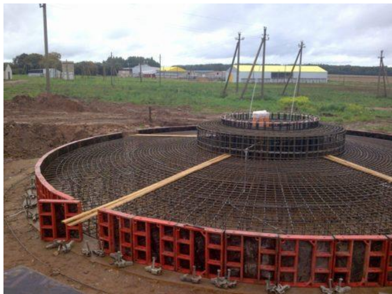
5.10-rasm. Samol elektr stansiyasining poydevorini quyish jarayoni.
