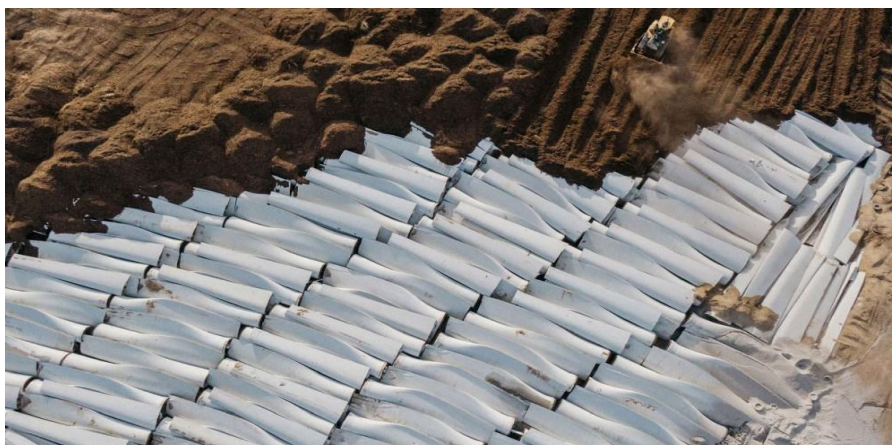
5.19-rasm. Shamol parraklarini erga ko‘mish jarayoni.
