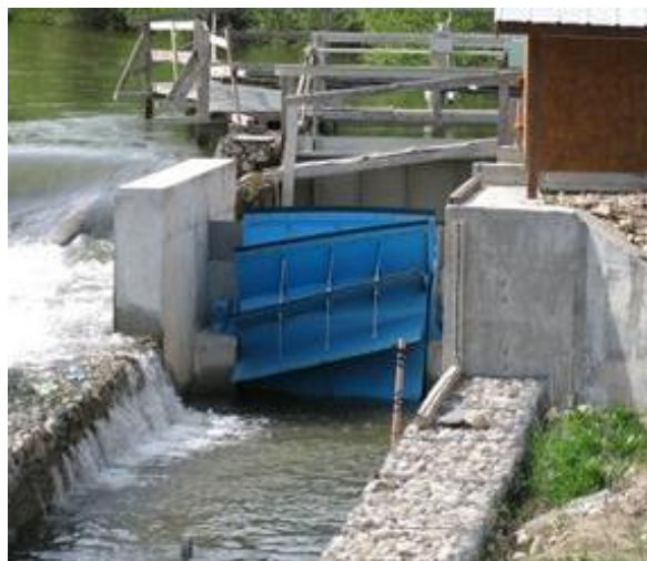
b) burama parrakli mikroGES ishlash jarayoni
