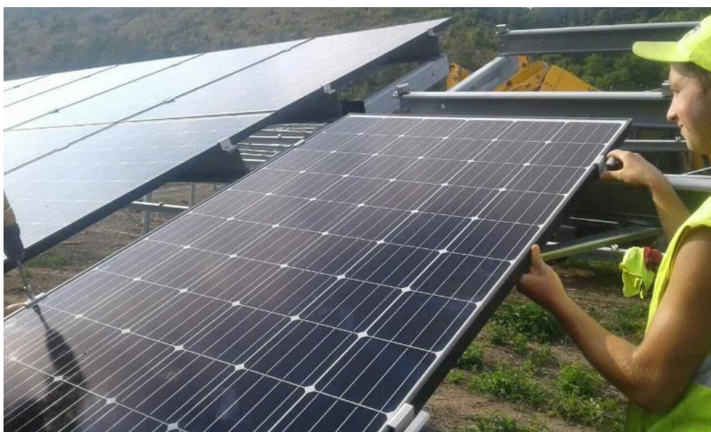
3.22-рasm. Қуёш фотоэлектрик станциясида қуёш панелларини мухандислар томонидан ўрнатиш
