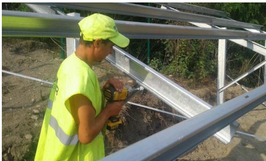
3.19-расм. Қуёш фотоэлектрик станциясининг каркас қисмини ўрнатиш
