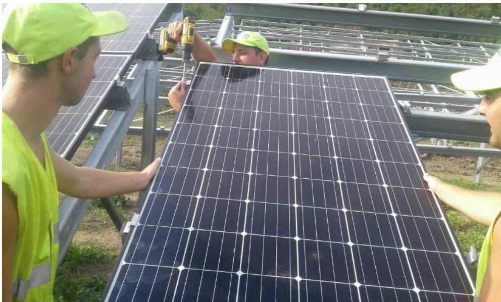
3.23-расм. Қуёш фотоэлектрик станциясида қуёш панелларини мухандислар томонидан ўрнатиш
