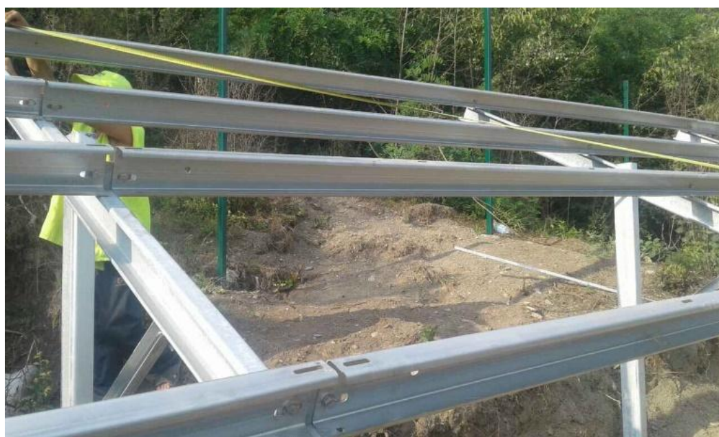
3.20-расм. Қуёш фотоэлектрик станциясининг каркас қисмини ўрнатиш
