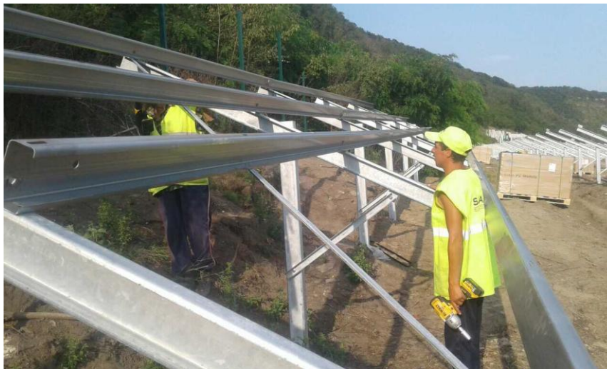
3.18-расм. Қуёш фотоэлектрик станциясининг каркас қисмини ўрнатиш
