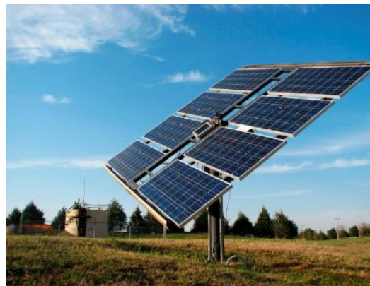
3.25-расм. Икки ўқли трекер қуёш электрик станцияси
