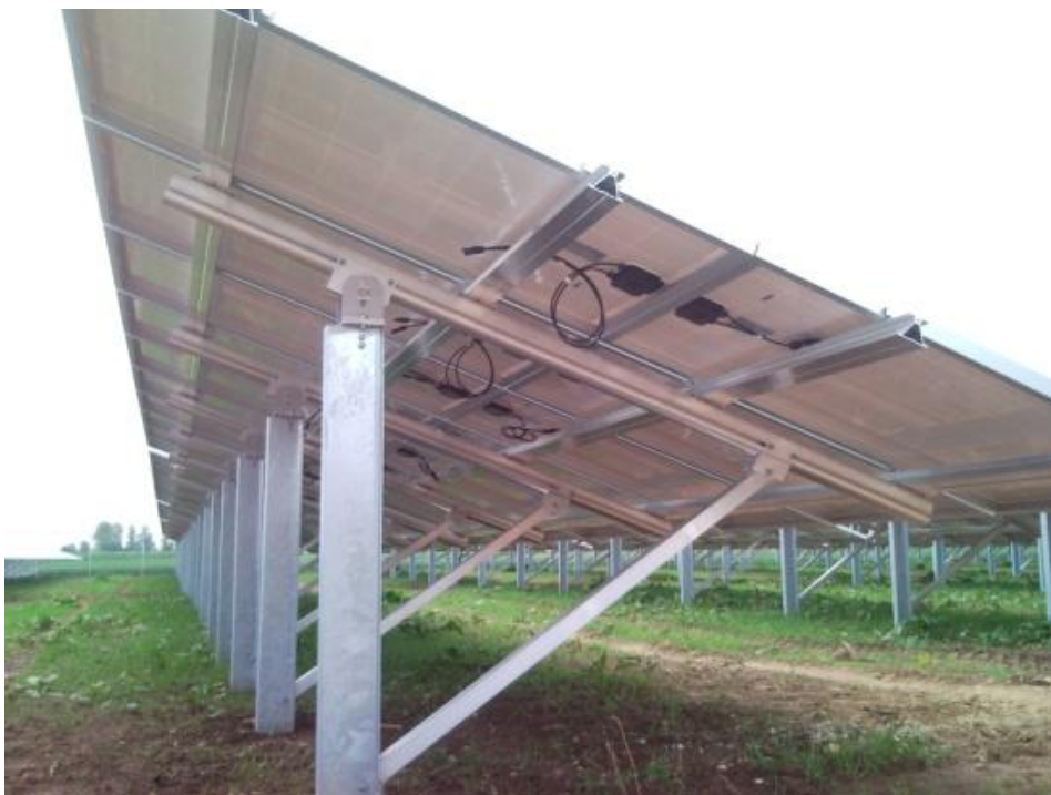
3.24-расм. Бир ўқли трекер қуёш электр станцияси
