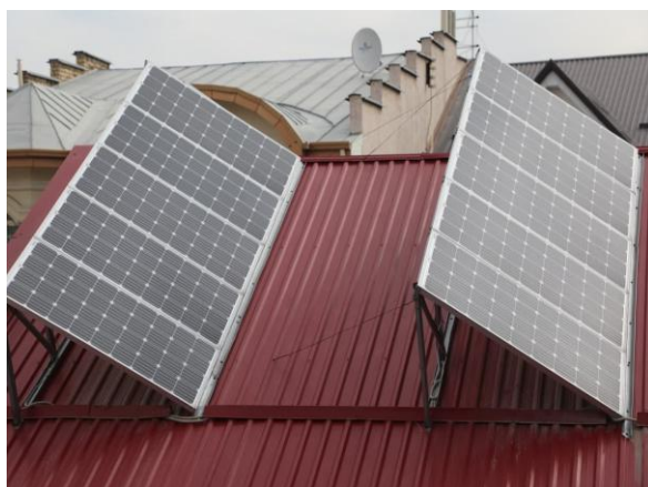
3.12-расм. Қуёш модули қурилмасини уй томида ўрнатилган ҳолати
