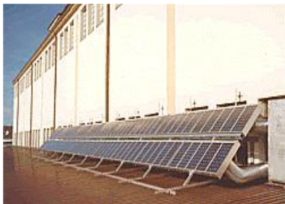
2.6-расм. SolarWall компанияси томонидан яратилган ҳаво фотоиссиқлик қурилмалари
