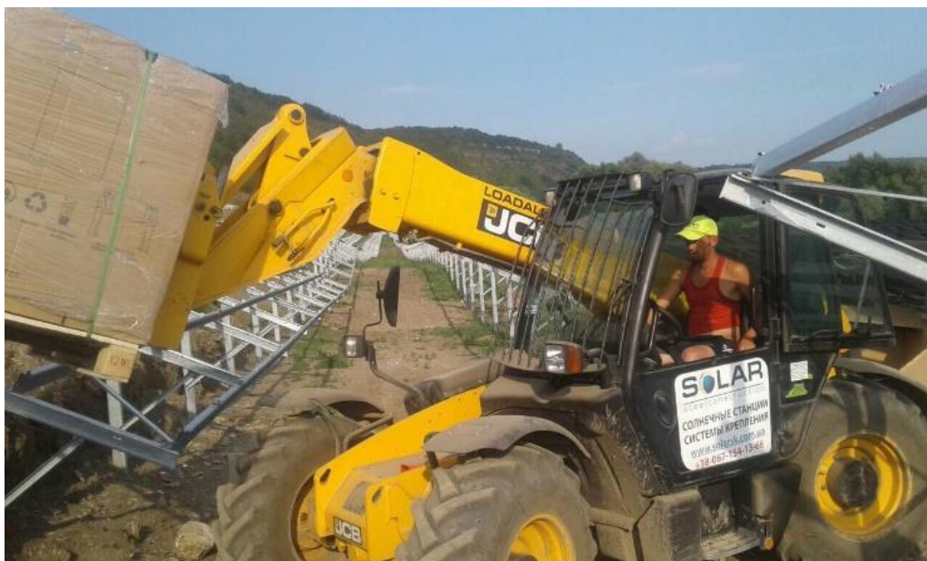
3.21-рasm. Қуёш фотоэлектрик станциясига қуёш панелларини транспортировка қилиш
